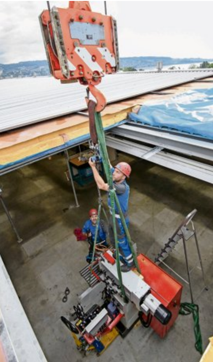
Die schweren Maschinen müssen zunächst transportfertig gemacht werden, bevor sie von einem Kran durch ein Loch im Dach in die Luft gehievt und auf einen Umzugswagen geladen werden.
