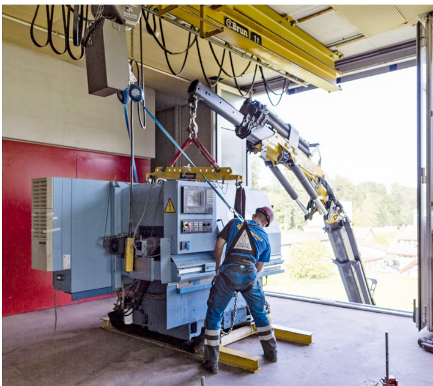
Standort Grünen: Abtransport einer Fräsmaschine (Profilator) von Lauschet und Partner vom 1. Obergeschoss auf den Kranlastwagen. (Bilder: Balz Murer)
