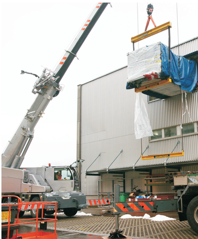
Die Werkzeugmaschine musste im zweiten Obergeschoss durch eine Fassadenöffnung eingebracht werden.
