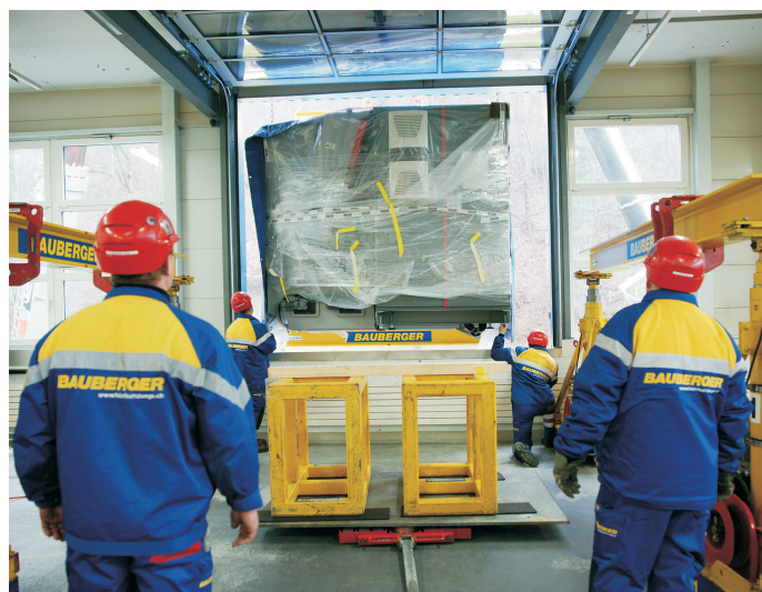
Millimeterarbeit – lediglich 80 mm höher als die Maschine war die Fassadenöffnung.
