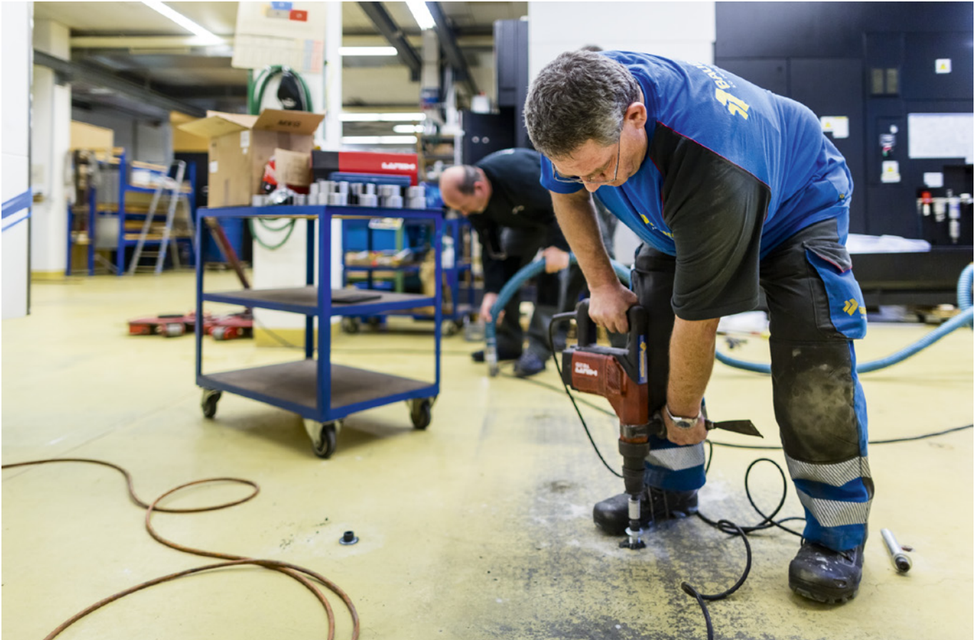
Montage der Gewindehülsen in die Kernlochbohrungen, damit die Gewindeschrauben ebenerdig platziert werden können.
