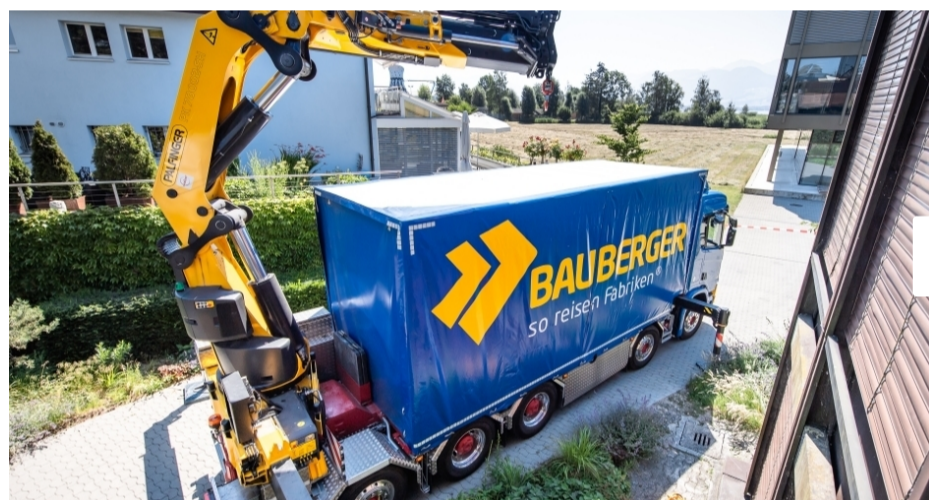
Zum Einsatz kam ein neues, innovatives mobiles Kranfahrzeug der Bauberger AG.
