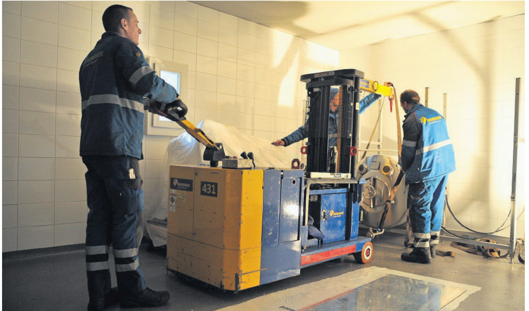
Mitarbeiter der Elgger Industrie-Umzugsfirma Bauberger installieren die 1000-Liter-Tanks. Ab Ende März lagern darin die ersten Fischinger Biere.
