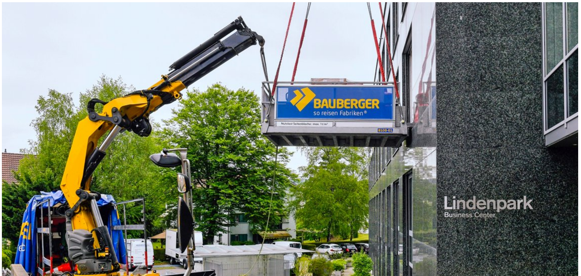
So reisen medizinische Hightechgeräte: Nach dem Sondertransport wird der 1,8 Tonnen schwere Computertomograf ins Innere des Gebäudes verfrachtet.
