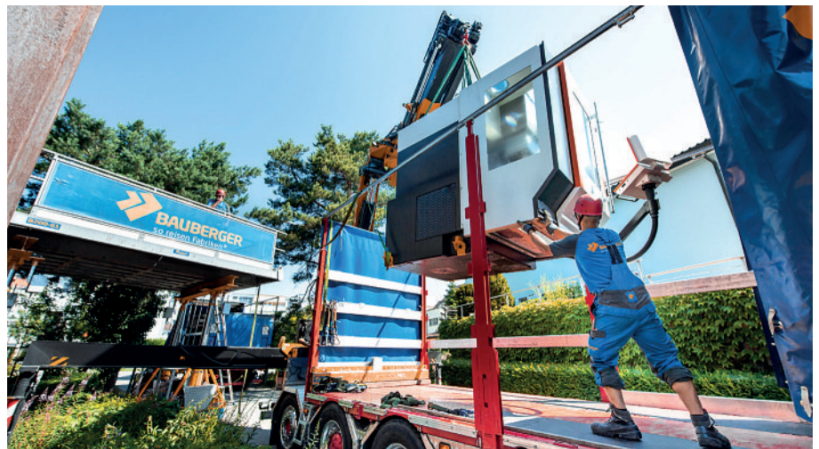
Bis zu zehn Tonnen schwere Maschinen wurden mit dem mobilen Kranfahrzeug verladen.
